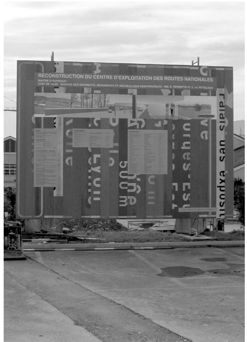
Le panneau de chantier, réalisé à partir de plaques signalétiques d'autoroute recyclées est représentatif d'une attitude générale adoptée pour le projet de Bursins: «La solution habituelle est-elle la meilleure?»
