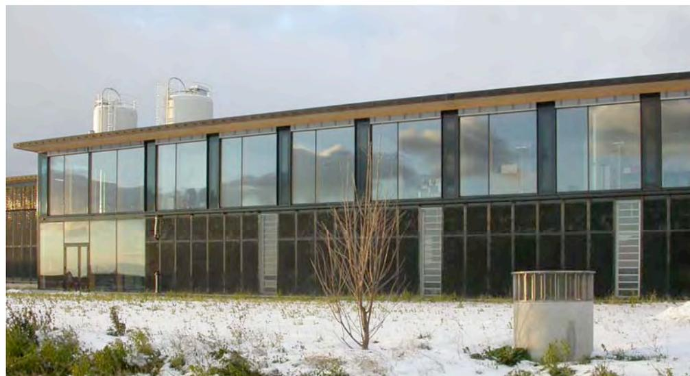
*La façade « solaire active et passive » couvre les 40% des besoins thermiques du bâtiment.*
