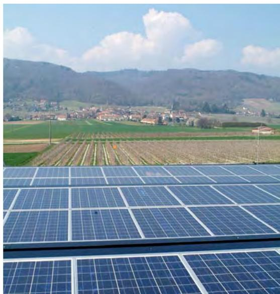
*L'installation photovoltaïque en toiture couvre les besoins électriques des installations techniques.*
